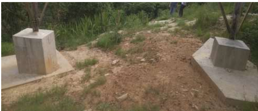
Figura 12: Reforços na fundação da torre de transmissão
