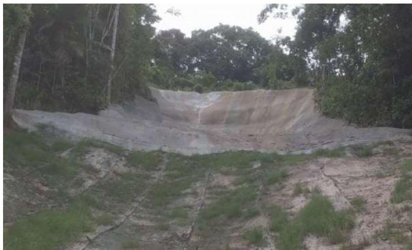
Figura 15: Contenção com solo grampeado e geomanta
