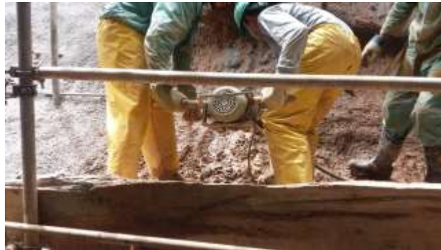
Figura 4: Perfuração do solo com a perfuratriz manual e lavagem com água
