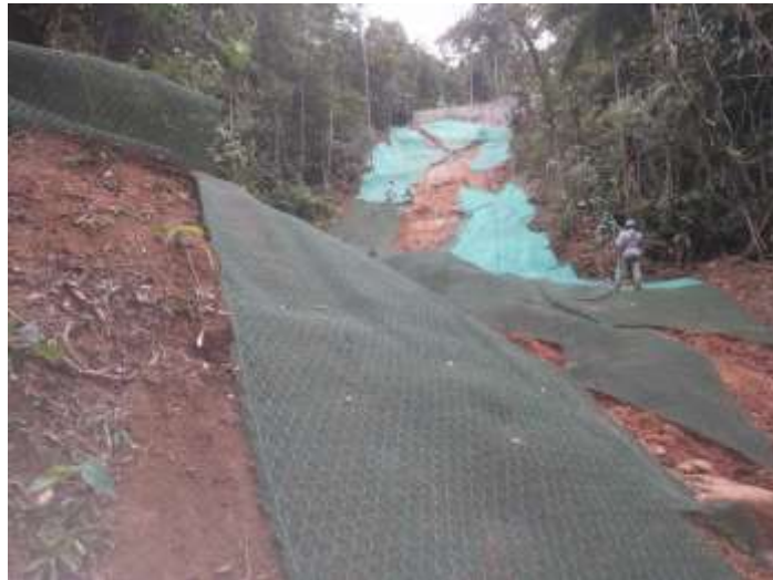
Figura 11: Instalação de geomantas com hidrossemeadura
