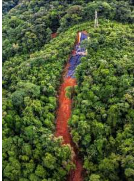
Figura 1: Vista aérea do escorregamento da encosta e a localização da torre de transmissão no topo à direita
