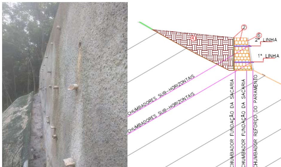
Figura 14: Face frontal e detalhe construtivo da berma de confinamento de material solto
