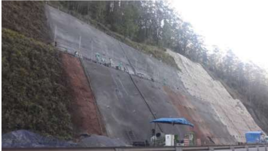
Foto 4: Contenção em Solo Grampeado finalizada
