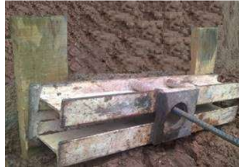
Foto 4: mesa de apoio sobre as vigas de madeira
