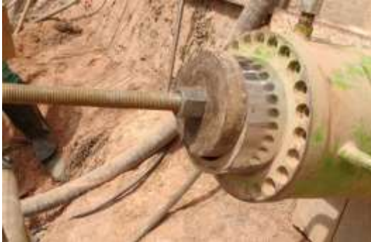
Foto 3: Montagem típica do conjunto de protensão
