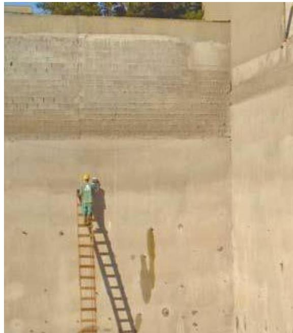
**Figura 11:** Leitura do extensômetro (fonte: Manual Solotrat, 2018, p. 19)
