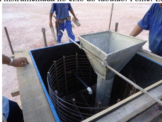
Figura 9. Concretagem do tubulão instrumentado. Fonte: Engeobase (2013)
