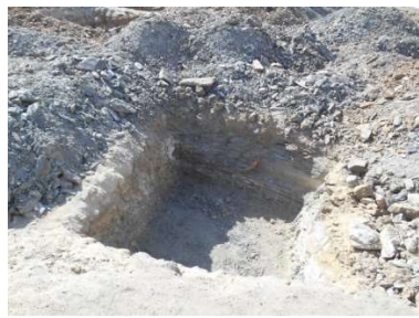
a) Expansão das cavas das sapatas
