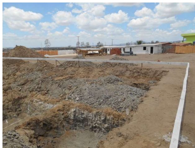
Figura 3. Escavações no terreno da obra (Município de Agrestina-PE)
