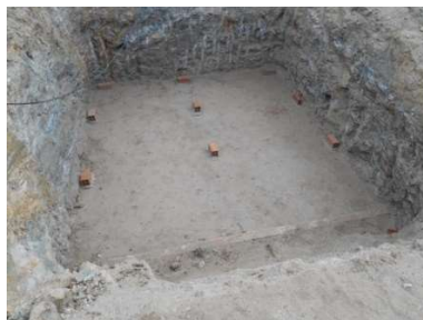
b) Mestras para concretagem da camada impermeabilizante de 10cm
