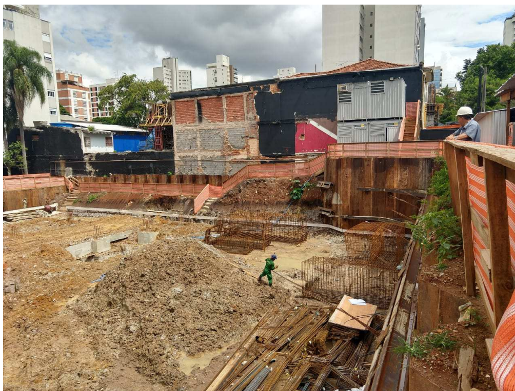
Fotografia 6: Vista do terreno em fase final de escavação (obra São Paulo)
