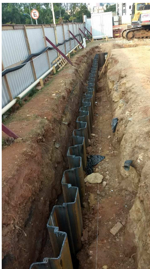
Fotografia 4: Vista de um trecho cravado da cortina (obra São Caetano do Sul)
