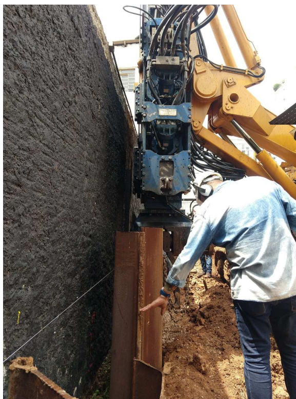
Fotografia 3: Detalhe da cravação junto à divisa (obra São Paulo)
