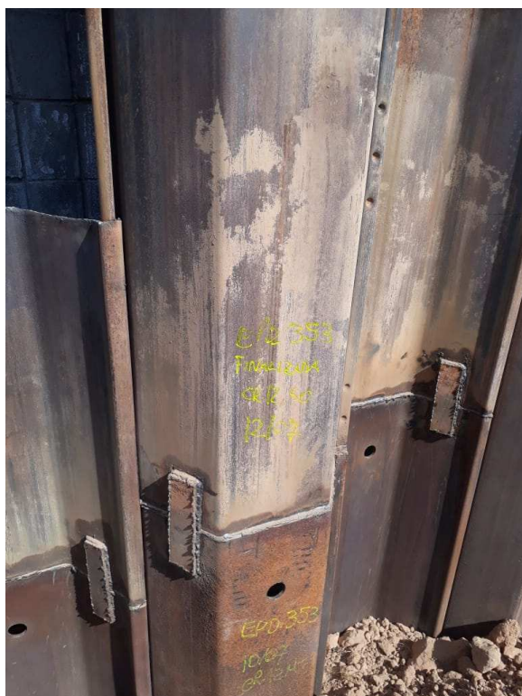
Fotografia 1: Detalhe das emendas das estacas (obra São Caetano do Sul)
