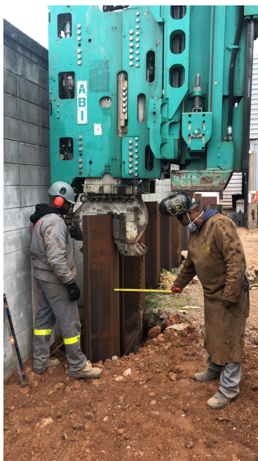
Fotografia 2: Detalhe da cravação junto à divisa (obra São Caetano do Sul)
