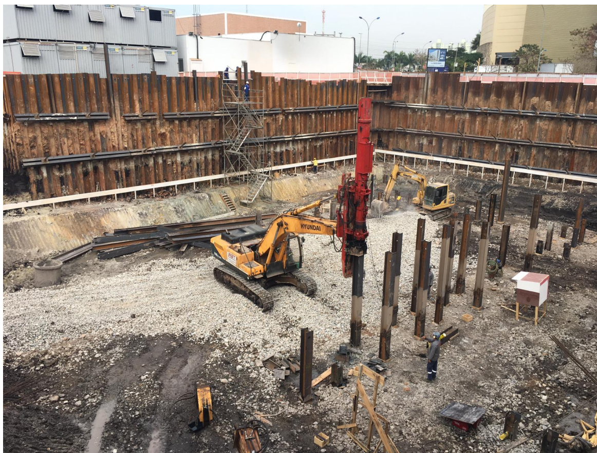
Fotografia 5: Vista da obra em fase de cravação das estacas de fundação (obra São Caetano do Sul)
