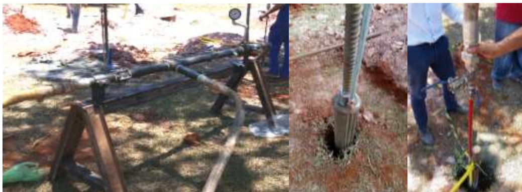
Figura 4- Sistema de injeção analógico – Cavalete de injeção, Dywexpander, e válvula de controle., Silva et al. (2018).
