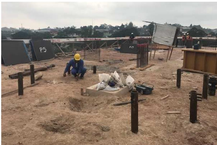
Figura 2. Estacas Posicionadas e Instaladas
