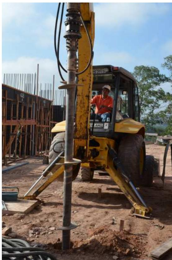
Figura 1. Instalação das Estacas Helicoidais Metálicas
