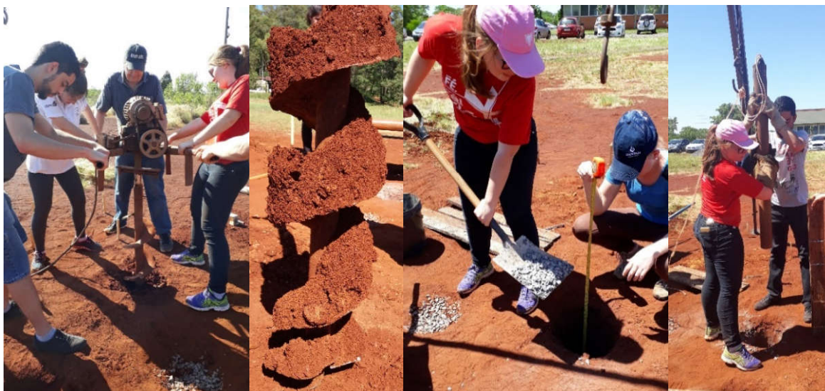
Figura 4. Preenchimento e compactação das colunas.
