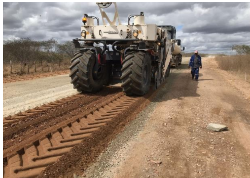
Figura 1. Recicladora em ação (próprio autor, 2018)
