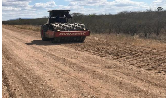
Figura 2. Compactação do solo (próprio autor, 2018)
